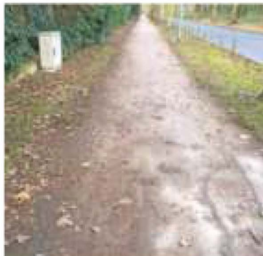
Der Rad- und Gehweg entlang der Hubertusstraße wird saniert. FOTO: GAP
