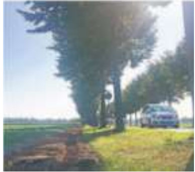
Der Radweg wird seit Montag von der Mags umgebaut.
