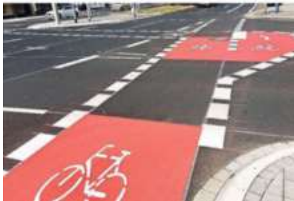
Die Markierung auf der sanierten Kreuzung Limitenstraße/Gracht: Radler können auch hier nur indirekt links abbiegen.
