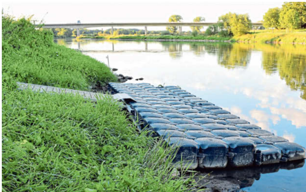
Ins Winterquartier: Der Bootsanleger setzt sich aus dem Steg und den Plattformelementen zusammen. Foto: Westermann
