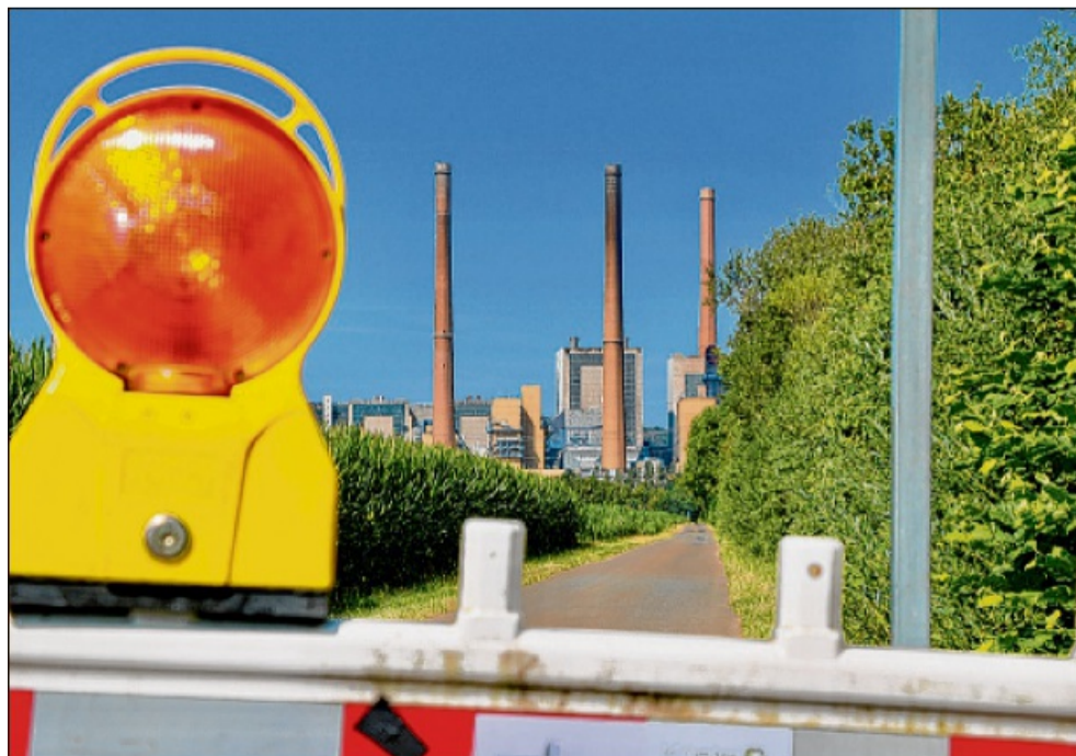
Absperrbaken sperren den Weg zum Kraftwerk in Veltheim. Dort hatte es vor Kurzem einen Großbrand gegeben. MT-Foto: Thomas Lieske
