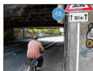
Zu schmal, dunkel und laut: Die Unterführung am Bahnhof. Foto: Hoffmeister
