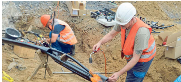
Vor Ort: Marc Rullmann und Frank Langemeyer beheben den Schaden an der Leitung. FOTO: JENY MÜLKEN
