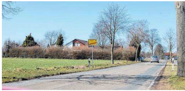
Weg mit der Buckelpiste: In Pr. Oldendorf wird die Decke der Lübbecke Straße (K 84) zwischen Hintern Kämpen (Halden) und L 557 (Bremer Straße) auf 2,5 Kilometern erneuert. FOTO: SANDRA SPIEKER-BEUTLER
