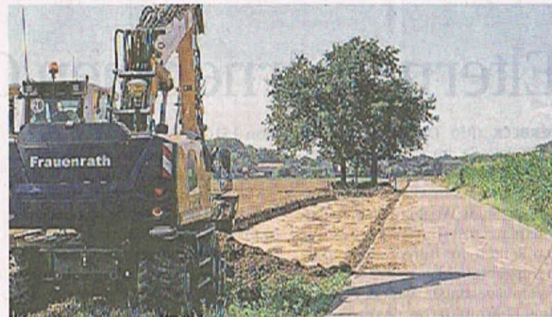
Der Elsumer Weg zwischen Birgelen und Ophoven ist gesperrt. Dort wurde eine weitere Baustelle eröffnet. Bis Schloss Elsum gibt es bereits seit geraumer Zeit einen Fuß- und Radweg. Dieser wird nun verlängert.
