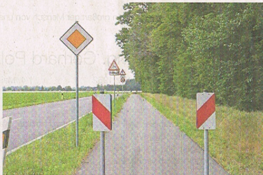
Der Radweg von Birgelen nach Effeld endet bisher an Schloss Elsum am Knotenpunkt 28. Ab hier wird es auf der schmalen Straße für Radfahrer zuweilen gefährlich. Deshalb soll der Radweg schon bald ausgebaut werden.
