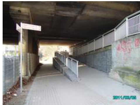
Verbindungsrampe unter Brücke der Alfredstraße
