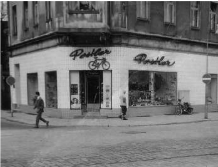
Das Fahrradgeschäft am Kesselbrink / Ecke Kavalleriestraße nach der Modernisierung
